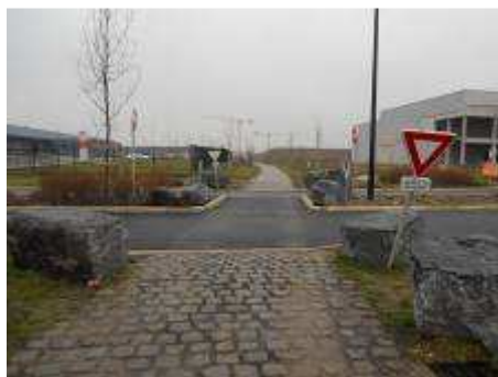
Traversée de la chaussée balisée (trajet menant à la gare de Lesquin)
