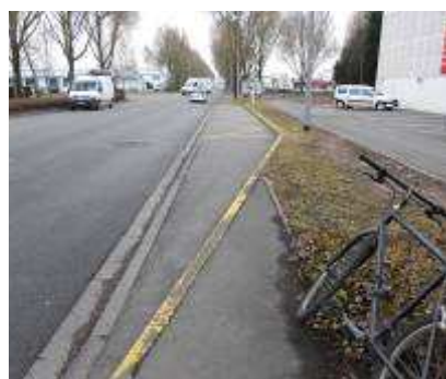
Discontinuité du trottoir au niveau de l'arrêt de bus – CRT3
