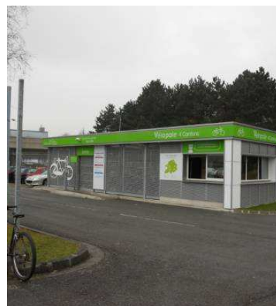
Vélopôle sur le parking relais de la station de métro 4 Cantons
