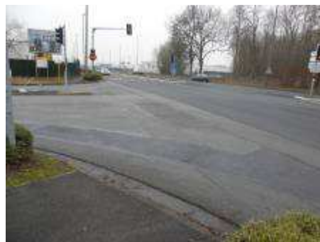
Discontinuité et absence de marquage – CRT1
